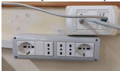
Configurazione prese aule didattiche scuola Secondaria
